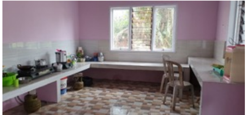
Renovierte Küche der Schule
